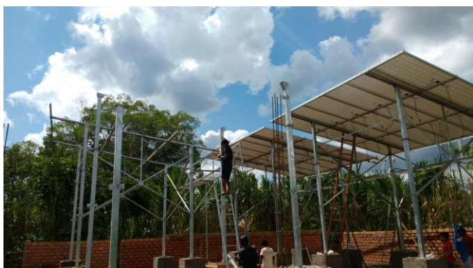
Cliente: Bitel Instalación de Paneles Solares Fotovoltaicos Loreto
