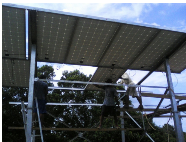
Cliente: Bitel Instalación de Paneles Solares Fotovoltaicos Chimbote
