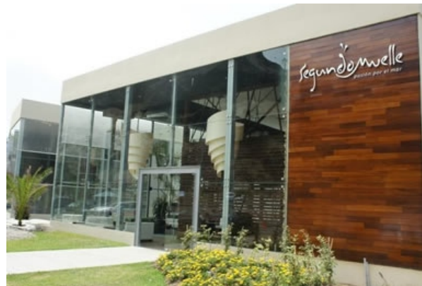
Cliente: Segundo Muelle Mantenimiento General.
