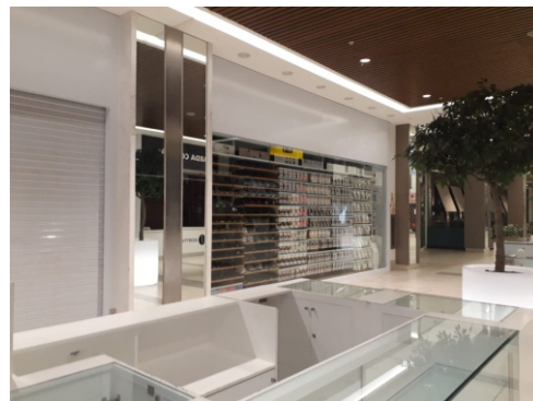
Instalación PAC fachada tienda Miniso - Jockey Plaza
