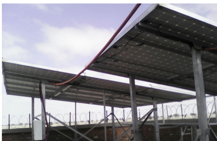
Cliente: Bitel Instalación de Paneles Solares Fotovoltaicos Piura
