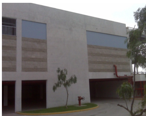
Trabajos Plaza Lima Norte- Solaqueado Sector 1
